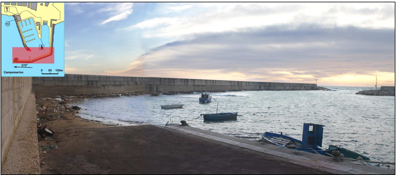
Area di intervento: fronte interno del molo di sopraflutto ed imbocco del porto
